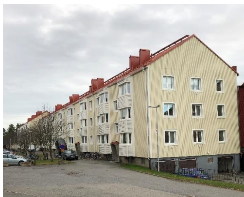
Bilden visar byggnad med plåtfasad
