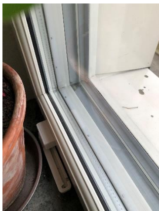
Bilderna visar treglasfönster
