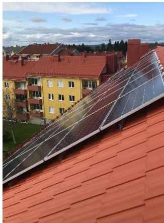
Bilden visar tak och solceller
