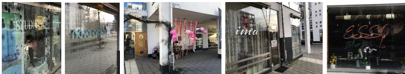
Fasadbilder på föreningens lokalhyresgäster
