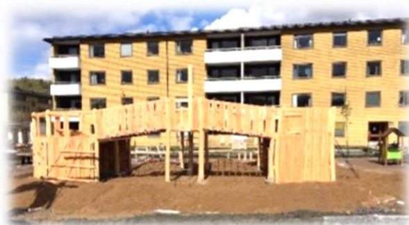
Ett sjörövarskepp under uppförande.
